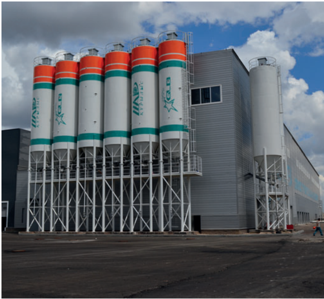
Mit der Lieferung und Errichtung der Betonmischanlage wurde die Teka Maschinenbau GmbH beauftragt.
