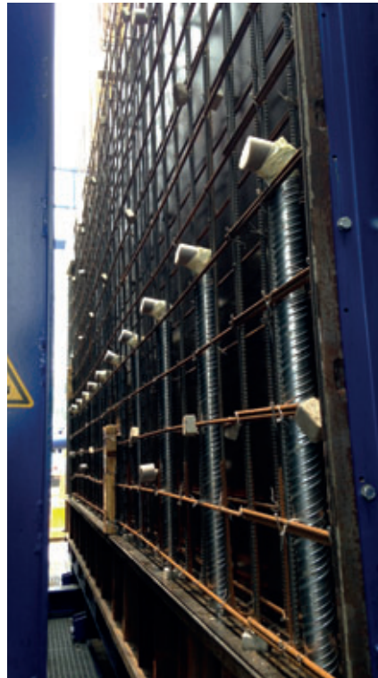
Blick in eine zum Betonieren vorbereitete Kammer
