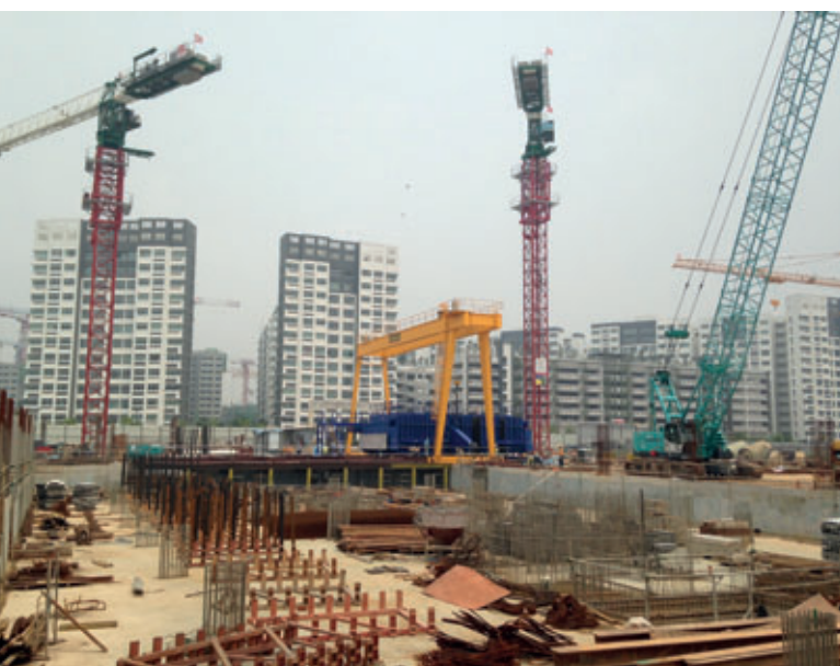
Die Mobile Batterieschalung (MBM) integriert in die Baustelle
