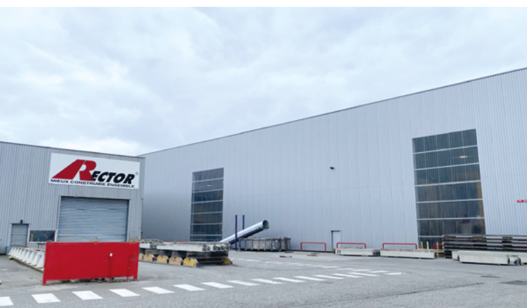
Nouveau hall avec un second système à circulation de palettes pour la production de prédalles et de prémurs
