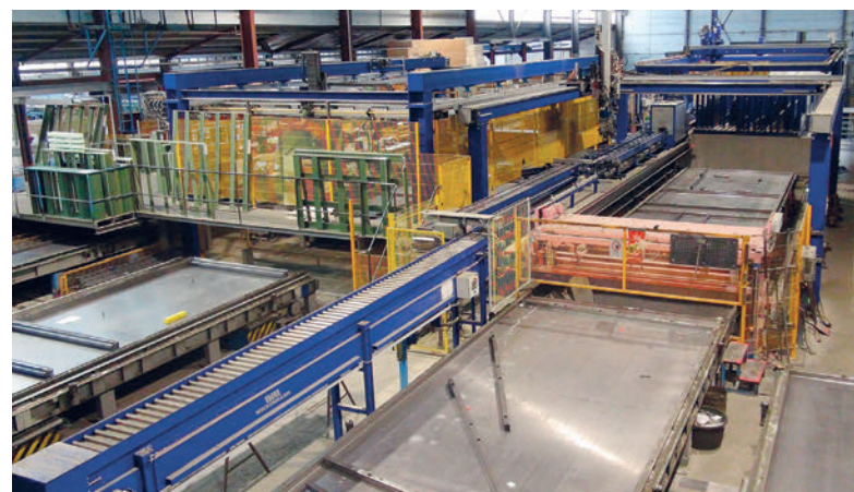
Fig. 2 Système complet comprenant la manutention des blocs magnétiques, le robot de décoffrage/coffrage (sur une position), le nettoyage des palettes et des coffrages, le robot de magasinage et le robot de positionnement des éléments à insérer
