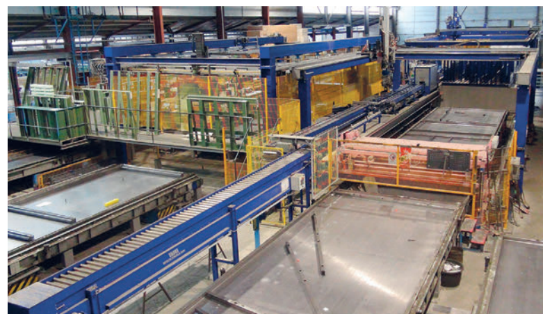
Fig. 2: Sistema completo con manejo de cajas de imanes, robot de encofrado/desenfofrado (en una posición), con limpieza de paletas y encofrado, robot de almacenamiento y robot colocador de accesorios
