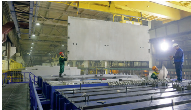
Suministro de los productos acabados
