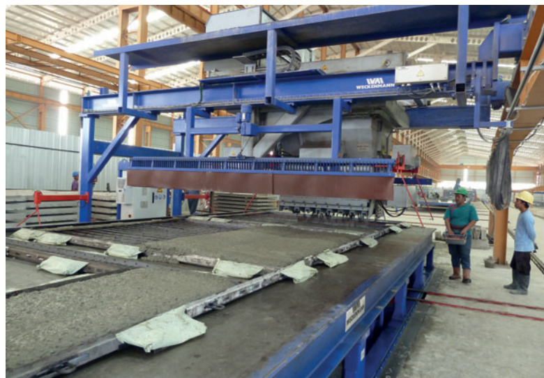
Distribuidor de concreto em uso
