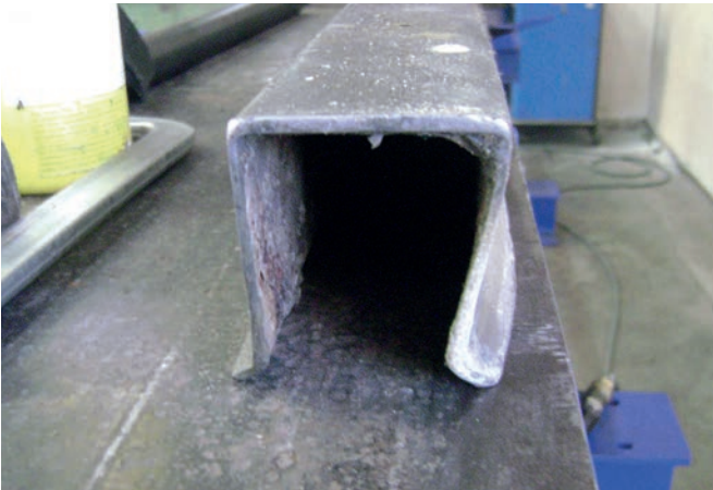
翻新前：变形和凹损的封堵模板系统
