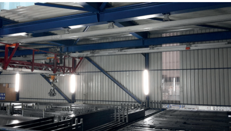
До модернизации: опалубочный участок на заводе АВІ в Бедбурге
