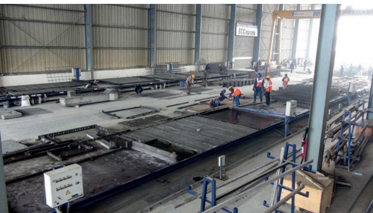
Producción de prelasas armadas y elementos especiales en la planta de elementos prefabricados de hormigón de Weckenmann en Bharat City, la India.
