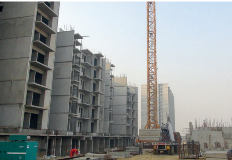
Bharat City, la India. Se están construyendo viviendas asequibles para numerosas familias indias.
